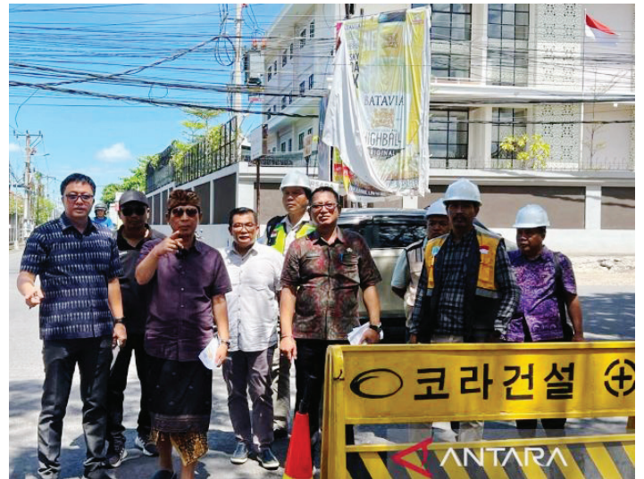
Proyek peningkatan ruas jalan di kawasan Pengubengan Kangin. ANTARA/HO-Pemkab Badung
