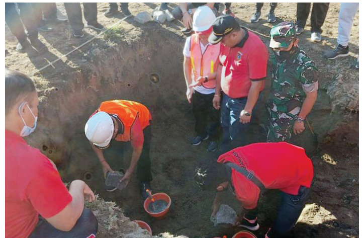
Acara peletakan batu pertama proyek pembangunan tribun Stadion Amlapura, Jumat (8/7/2022). ANTARA/HO-Pemkab Karangasem.
