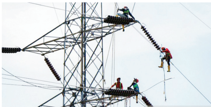
PLN percepat penyelesaian infrastruktur listrik di Bali untuk G20 (ANTARA/HO-Humas PLN)
