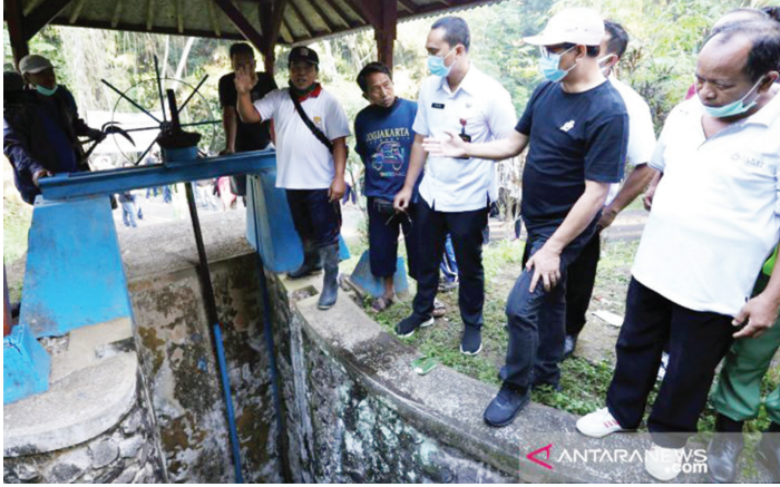
Wabup Badung I Ketut Suiasa meninjau saluran irigasi Subak Yeh Penet Desa Penarungan yang bertempat di lingkungan Banjar Bantas, Desa Penarungan, Kecamatan Mengwi, Rabu (19/8). Antaranews Bali/Naufak Fikri
