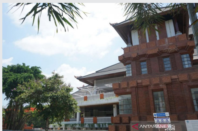
Pembangunan Balai Budaya Denpasar segera rampung. (Antaraneews/Komang Suparta/IST/2019)
