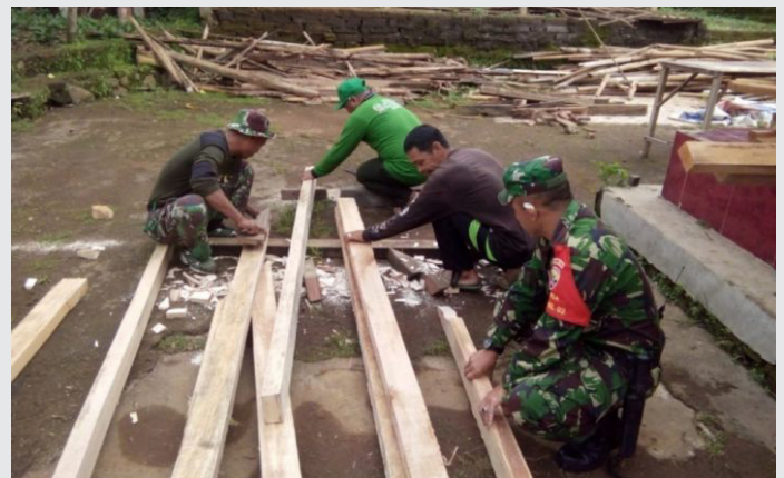
Ilustrasi-Anggota TNI membantu melakukan perbaikan rumah warga kurang mampu (Antaraneews Bali/Humas Korem 163 Wira Satya/I Made Surya)
