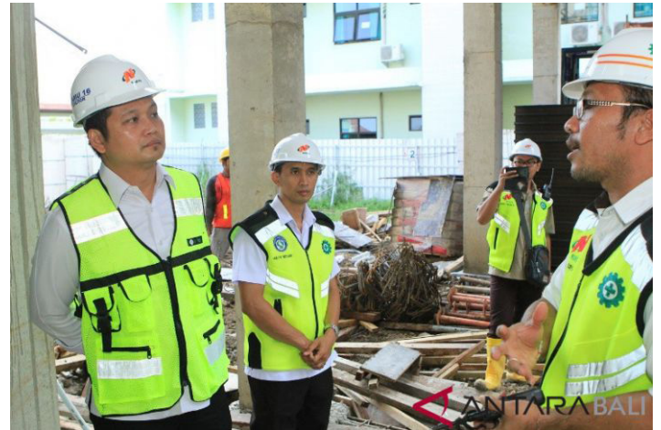
Wakil Bupati Jembrana I Made Kembang Hartawan (paling kiri) mendengarkan penjelasan dari rekanan terkait kemajuan proyek pembangunan RSU Negara, Kamis (3/1). (Antaraneews Bali/Humas Jembrana)
