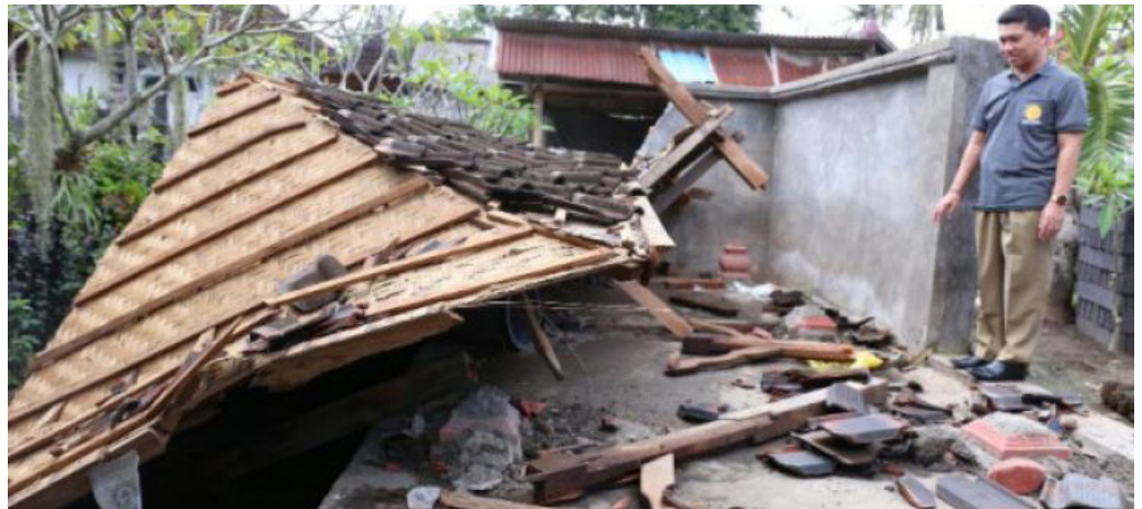
Bupati Klungkung I Nyoman Suwirta meninjau ke sejumlah bangunan yang rusak dampak pasca Gempa 7,0 SR yang terjadi di Lombok Nusa Tenggara Barat. (Antaraneews Bali via Humas Pemkab Klungkung)
